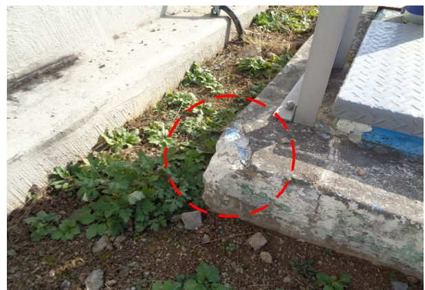
외부 바닥, 콘크리트 파손 (A=0.5m×0.5m)
