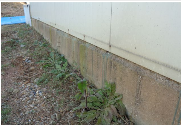
외부 바닥 전경(양호)
