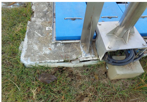
1층 내부 (연결동) 바닥 콘크리트 박리 및 박락 (A=4.0m×0.5m)
