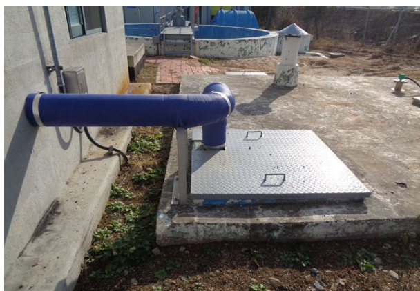
외부 바닥, 콘크리트 파손 (A=0.5m×0.5m)
